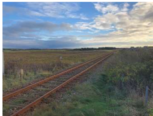
Jernbanen langs vestsiden af lokalplanområdet.
